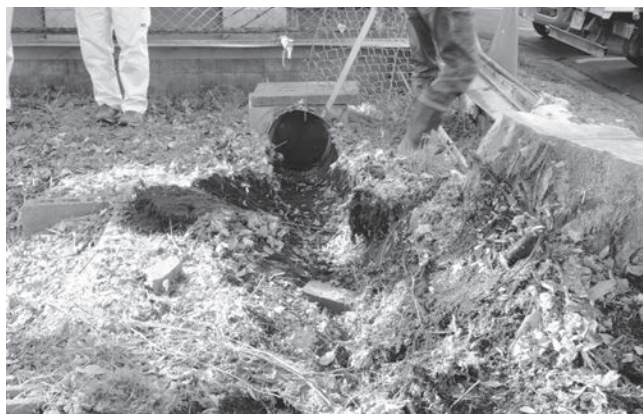
写真44 ヒューム管撤去状況（北より）
