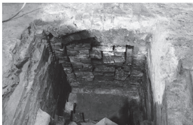
写真57 小資料室内旧ボイラー大煙道断面検出状況（西より）
