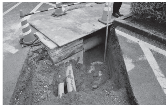
写真121 既設雨水管周辺掘削完了状況（北より）
