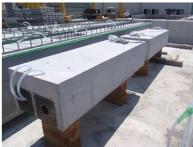
写真 6.4.1 セグメント製作後の状況
