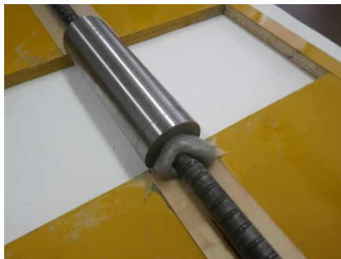
写真 4.2.2 充填材充填状況
