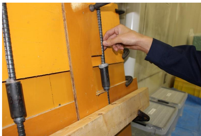
写真 4.4.1 供試体組立状況
