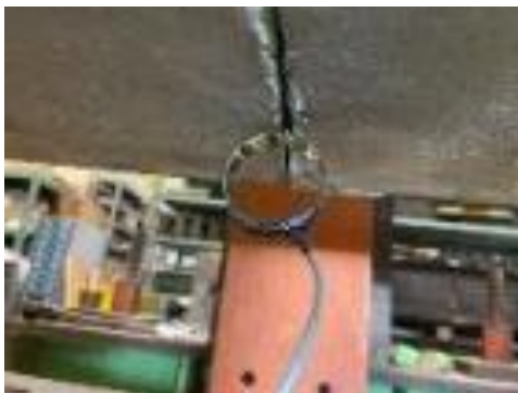
写真 5.3.1 クリップゲージ設置状況
