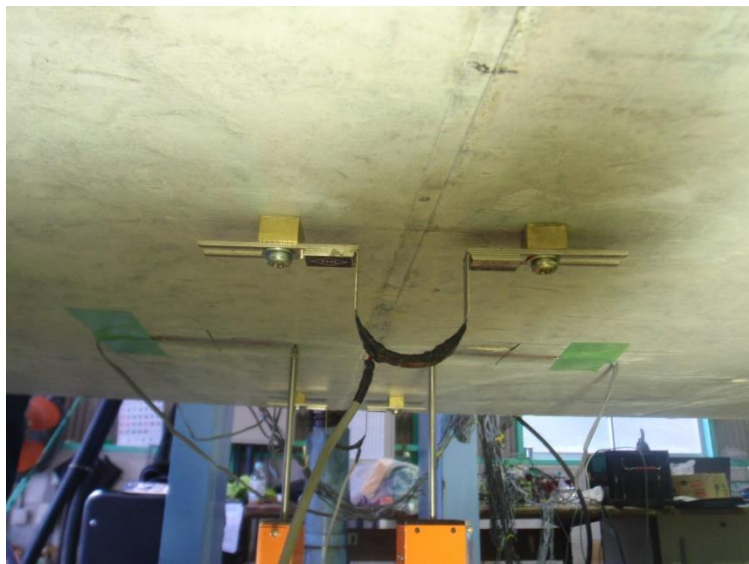
写真 6.4.6 パイ型変位計取付状況
