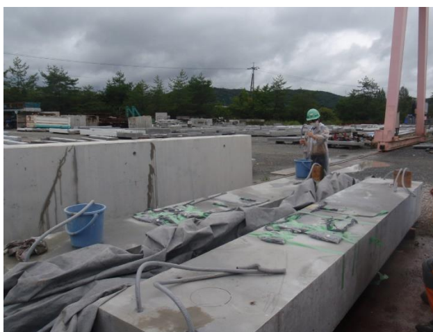
写真 6.4.5 グラウト作業
