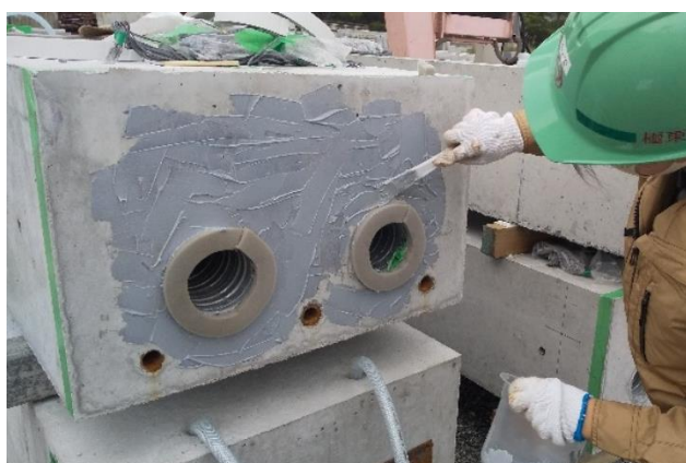
写真 6.4.2 セグメント接合面の接着剤塗布状況
