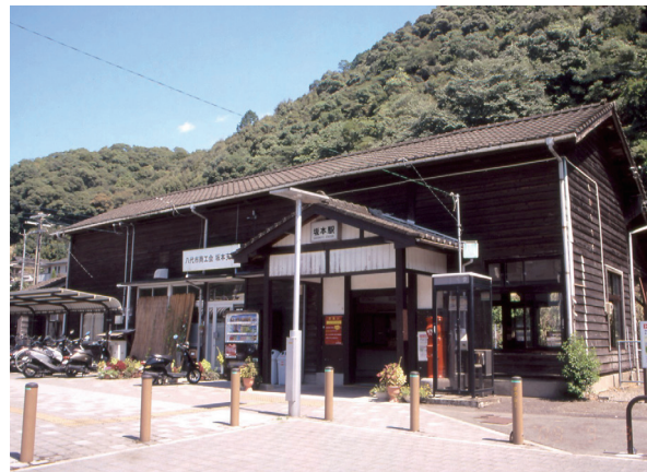
坂本駅舎 磯田撮影
