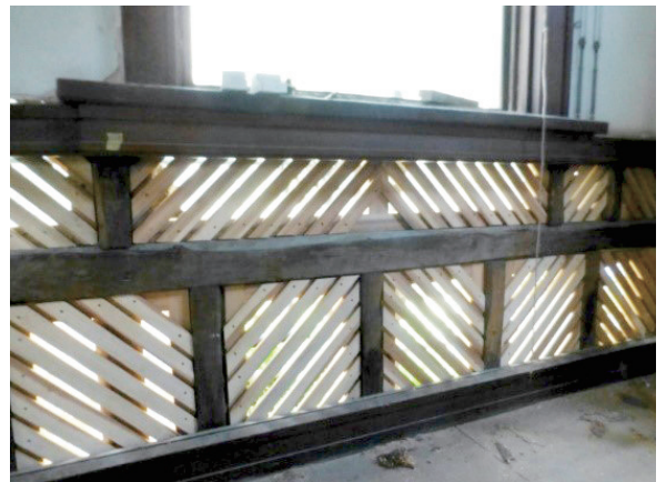
洋間腰壁 木摺補強 撮影坂田
