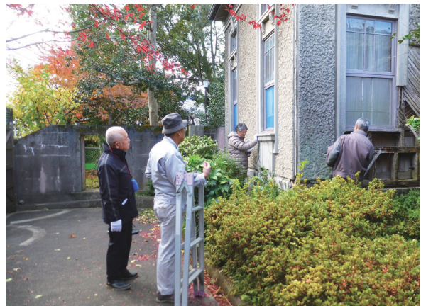
洋間外壁状況調査 撮影井田
