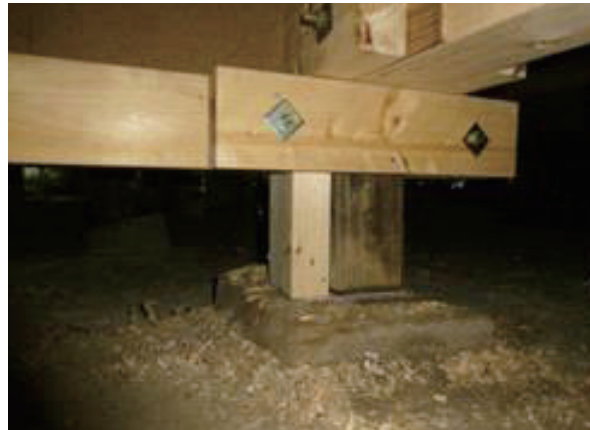
床下根固め補強 撮影坂田
