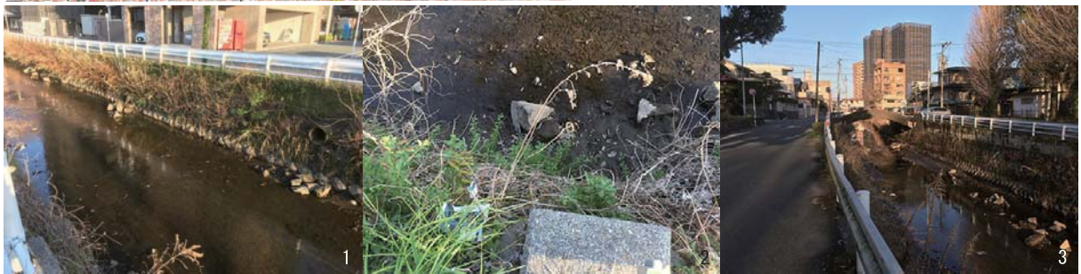
①付近の大井手の底の間知石（西より） ①付近の大井手の底の間知石（北より） ②付近の大井手（西より）
