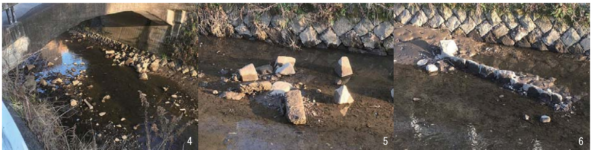
②付近の宮の本橋の下（北西より） ②付近の大井手の底の間知石（北より） ②付近の大井手の底の石垣（北より）
