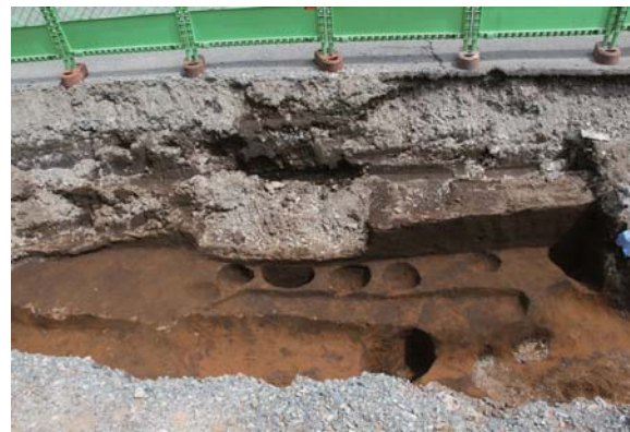
写真 88 12区拡張部掘削状況（北西より）
