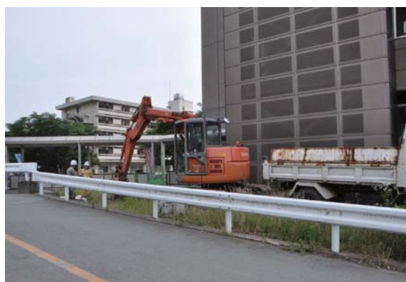
写真 253 9・11区作業風景（南より）
