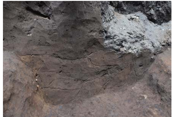
写真 147 16区1・2号溝土層断面（南より）
