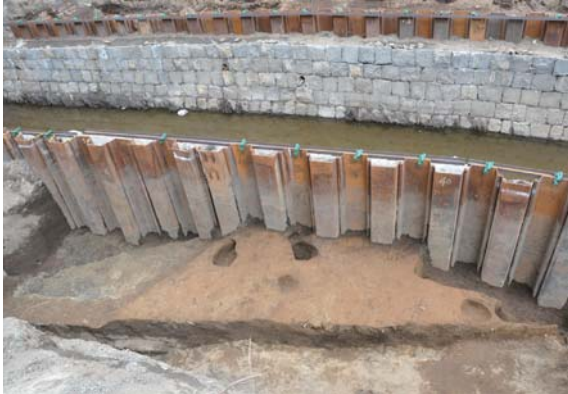
写真1 1区完掘状況（西より）
