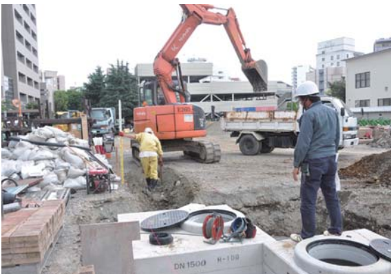
写真 247 7区作業風景（南西より）
