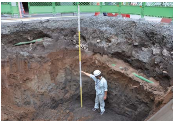
写真 180 19区地層堆積状況（西より）
