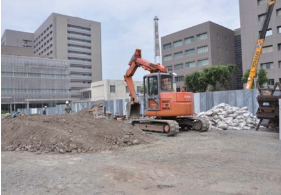
写真 243 6区作業風景（東より）
