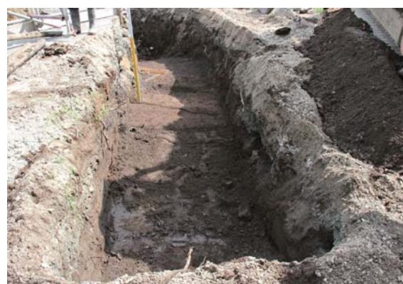
写真 258 14区掘削状況（北より）
