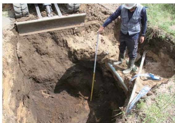
写真 254 9・11区掘削状況（北西より）
