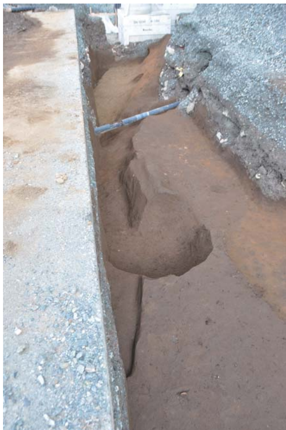
写真 168 20区1号溝掘削状況（南東より）
