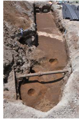
写真 264 17区遺構面掘削状況（北東より）
