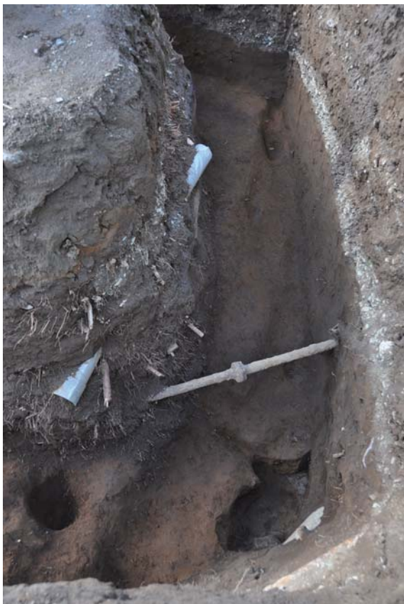
写真 240 36・37区北西側1号溝掘削状況（北東より）
