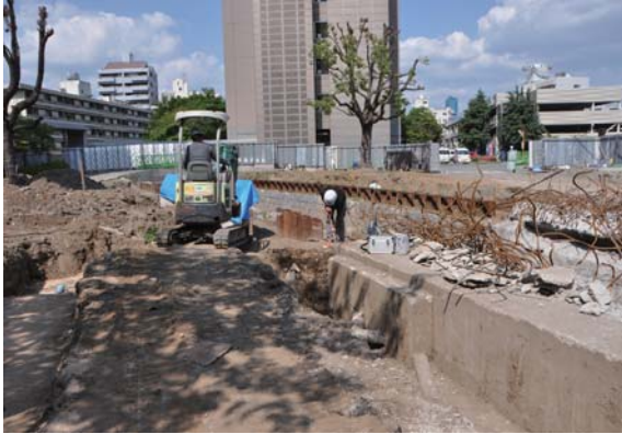
写真27 4区作業風景（南西より）
