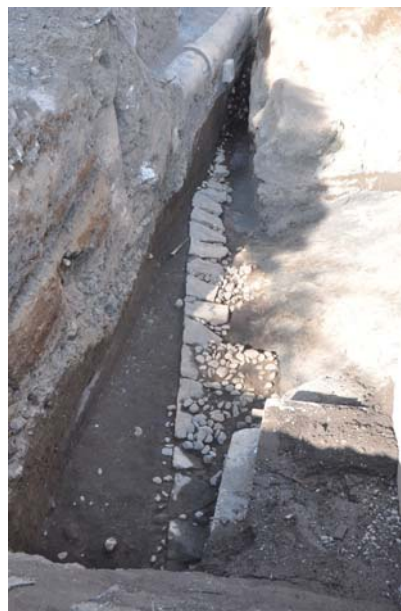
写真 197 30区石垣検出状況（南より）
