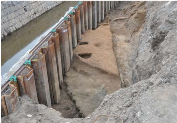
写真3 1区完掘状況（北より）
