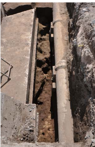
写真 190 30 区北半掘削状況（北西より）
