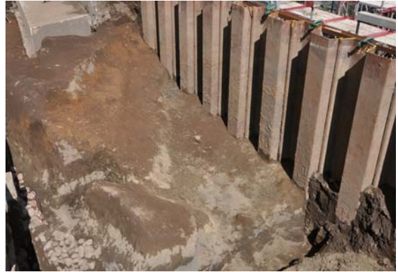
写真 193 30区1号溝完掘状況（南西より）
