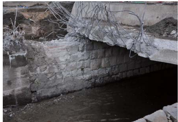
写真 211 30区暗渠の石垣(南東より)
