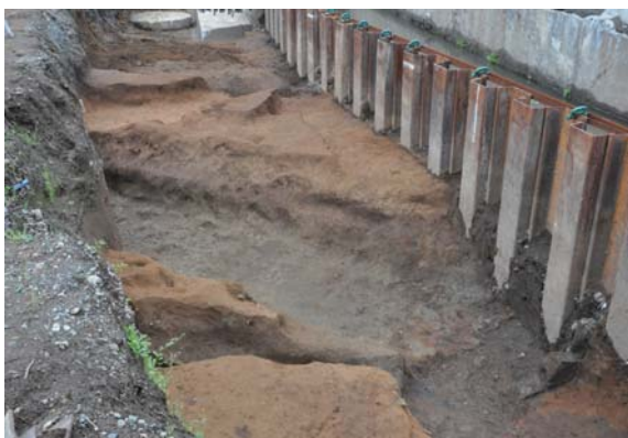
写真18 2区21号溝完掘状況（南西より）
