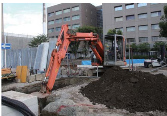
写真 257 14区作業風景（南より）
