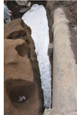
写真 209 30区保護不織布敷設状況(北西より)
