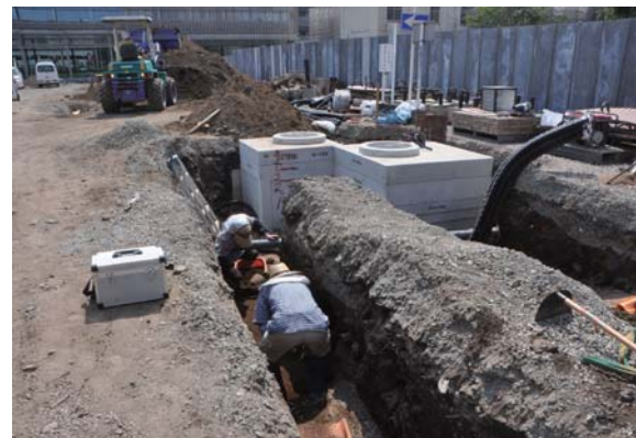
写真 248 7区南路線作業風景（北東より）
