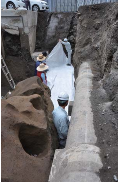
写真 208 30区保護不織布敷設作業(北西より)
