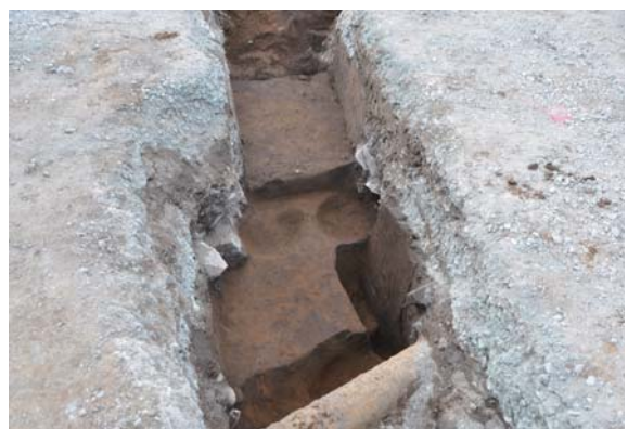
写真 282 25区完掘状況（南より）
