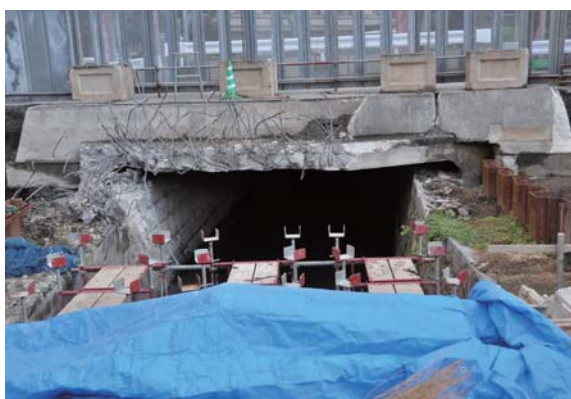
写真 184 三の井手のカルバート構造（南西より）
