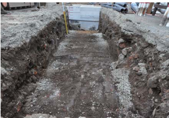
写真 249 7区掘削状況（北東より）
