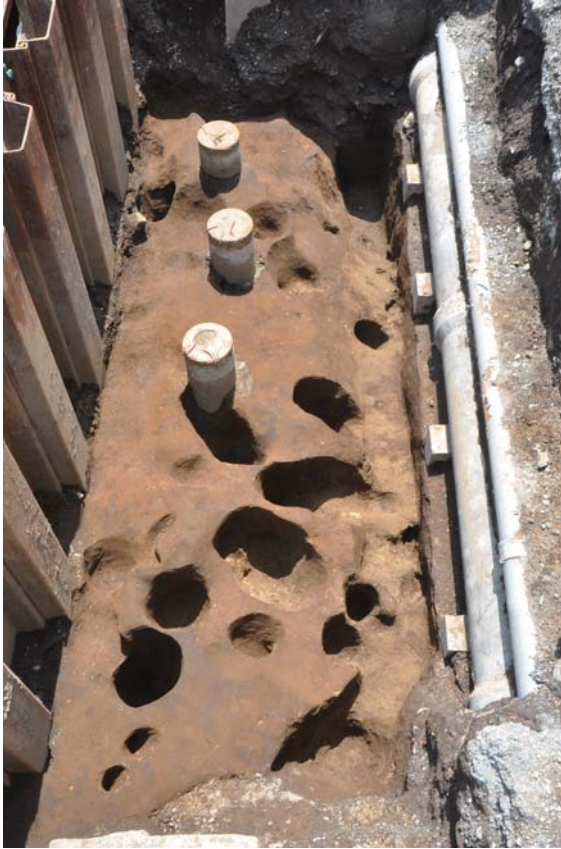
写真 41 5区完掘状況（北東より）
