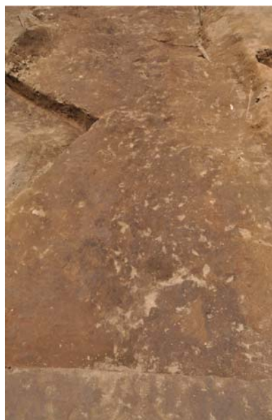
写真21 2区18号溝ベルト南側鉱物沈着状況(北北東より)
