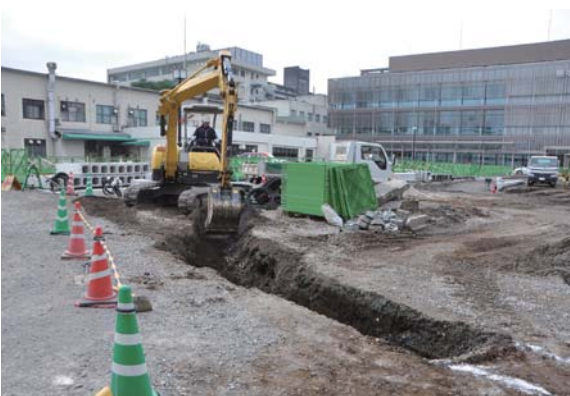
写真 281 25区作業風景（北東より）
