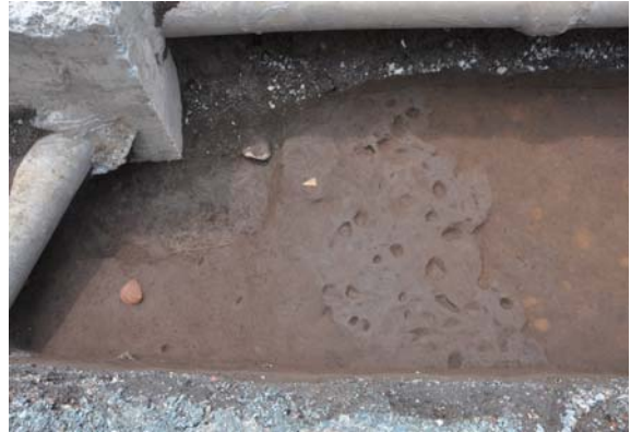
写真 100 12区2号硬化面検出状況（北より）
