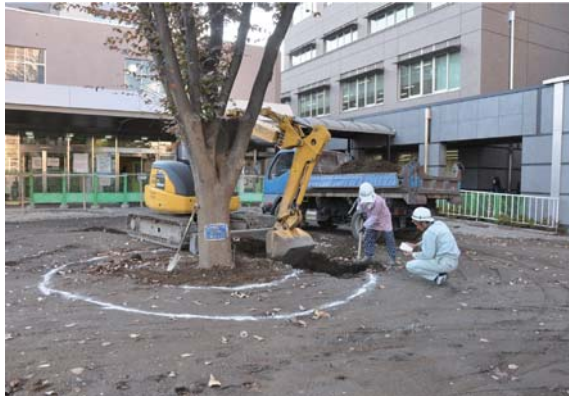
写真 238 36・37区作業風景（東より）
