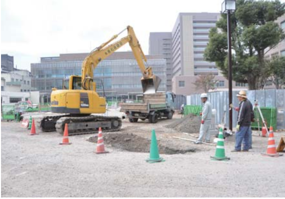
写真 229 35 区作業風景（北東より）
